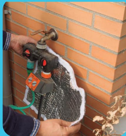
Los aislantes **PolyREFLEX** de **Optimer System** están fabricados con dos láminas de **aluminio puro**, unidas por una cámara de aire de **5 mm**, que ofrecen una gran capacidad de **aislamiento térmico**.
