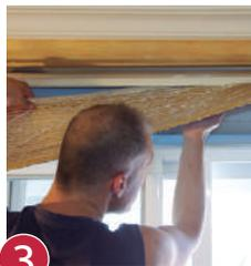
**3** Pega la lámina aislante en el interior del cajón y en la parte superior.
