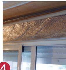
**4** Pega la lámina aislante en la parte inferior y coloca la tapa del cajón para finalizar la instalación.
