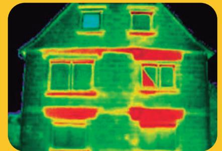
Como se aprecia en la termografía las zonas de los cajones de las persianas, son grandes puentes térmicos que facilitan la entrada del frío o del calor a la vivienda. **Evítelo con nuestras láminas aislantes Optimer System.**
