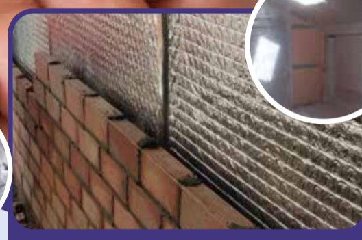
Paredes y trasdosados
