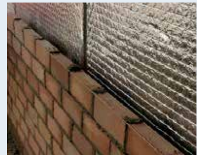
2 Paredes y trasdosados
