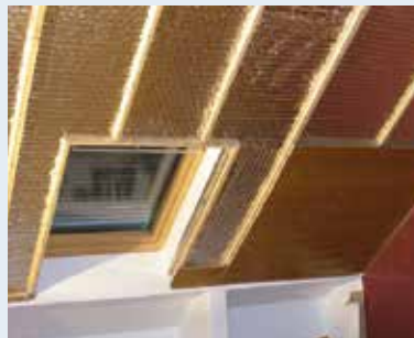
1 Techos y buhardillas
