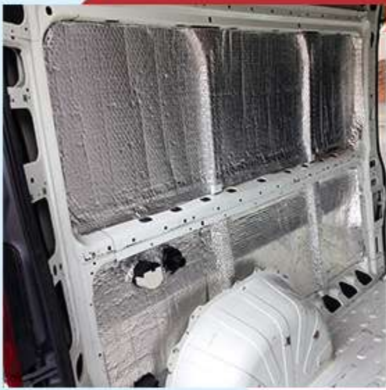
Aislamiento en paredes
