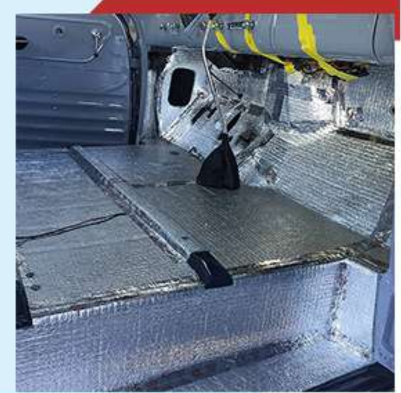
Aislamiento zonas críticas
