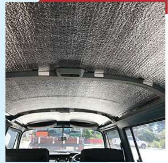
Aislamiento en techo
