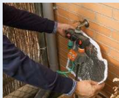
3 Contadores de agua
