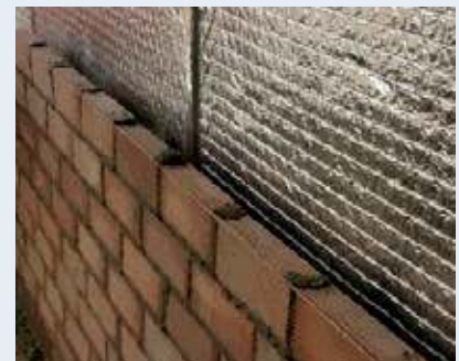
2 Paredes y trasdosados
